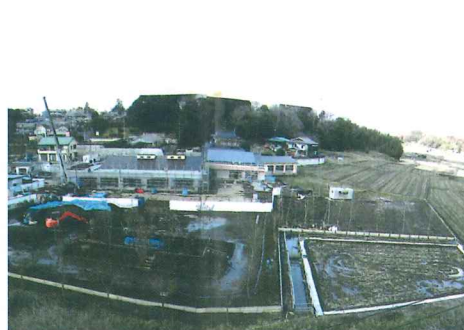
建設中の青空保育園
